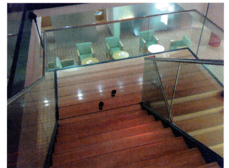
Abb. 7: Treppe, die das visuelle System fordert (Streifenmuster, Spiegelung, Distanzen).
